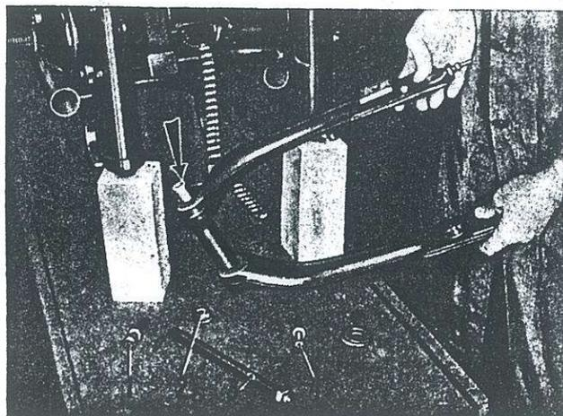
Bild 186. Hinterfedergabel ausgebaut
