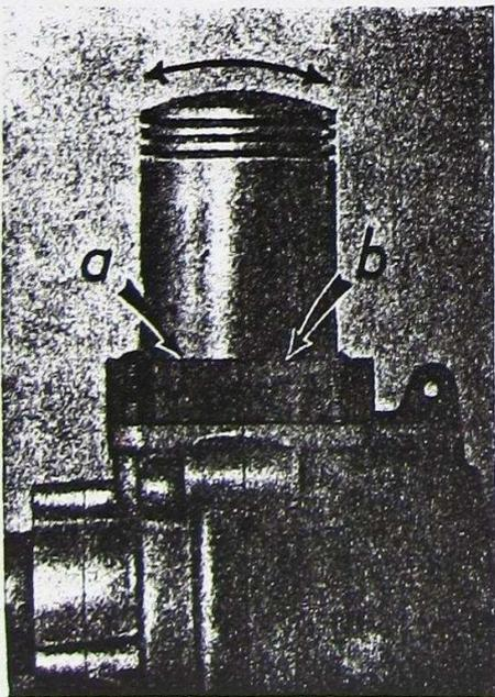
Bild 111. Prüfen des Kolbens auf Verwindung. Bei abwechselndem Drehen nach rechts und links muß bei a und b der gleiche Lichtspalt sichtbar sein
